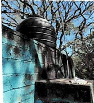
Foto 7: mejoramiento de tubería de rotoplast y baños del establecimiento
