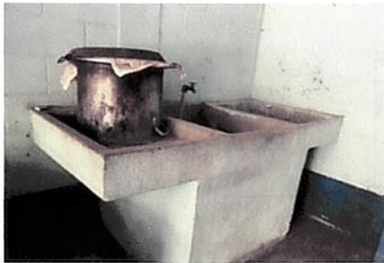
Foto 5: reconstrucción de pila de cocina.
