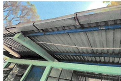
Foto 12: cambio de lamina troquelada.
