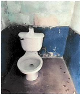
Foto 9: mejoramiento de los baños y accesorios
