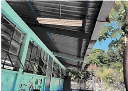
Foto 3: cambio de toda la instalación electrica y cambio de 12 candelas por 12 lamparas.
