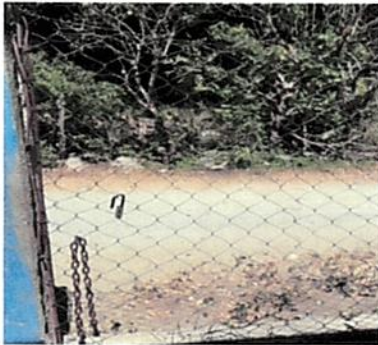
Foto1: colocacion de malla frente para protección del establecimiento.
