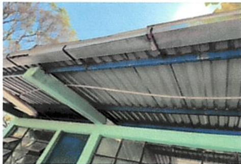
Foto 11: cambio de canales y caídas de agua.
