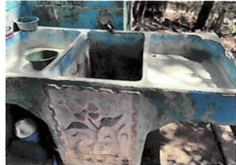
Foto 10: cambio de pila que se utiliza para el lavado de manos y trapeadores del establecimiento.
